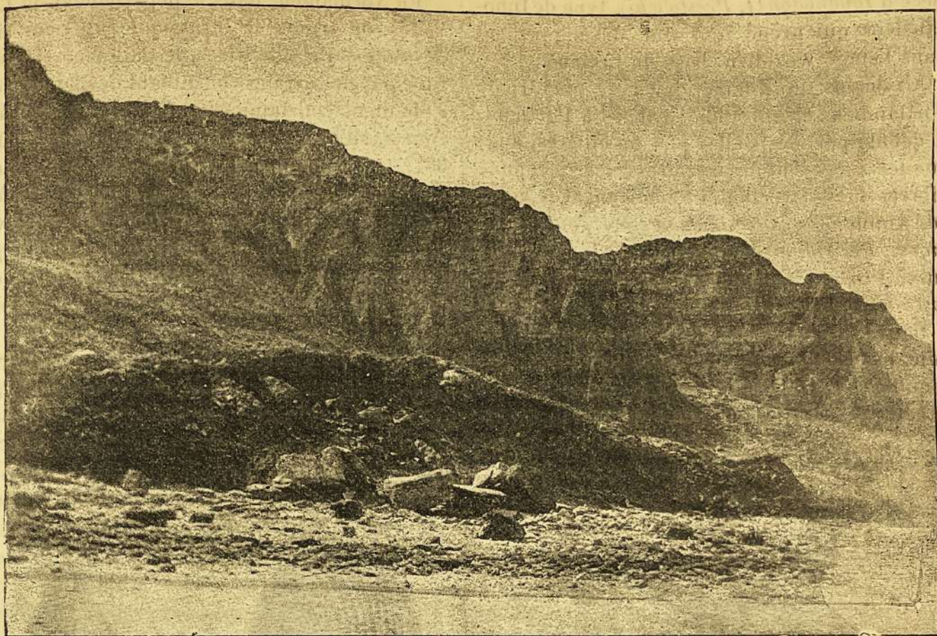
Fig. 380. — Vue d'une falaise près de Villers-sur-Mer montrant les blocs éboulés (photographie communiquée par M. Vélain).
